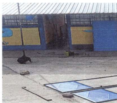
Foto 4: sustitucion de puertas de metal por metal.
