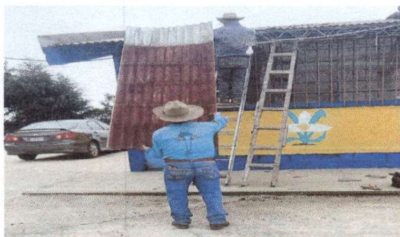
Foto1: Sustitucion de lamina por lamina troquelada calibre 26
