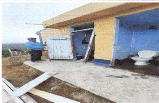
Foto 5: Sustitucion de puertas de baño de madera por puertas de metal
